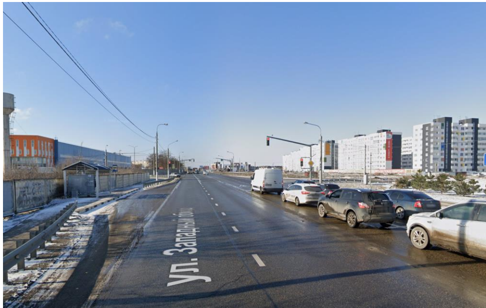
Рисунок 1.7.1 – Существующее положение ул. Западный обход
