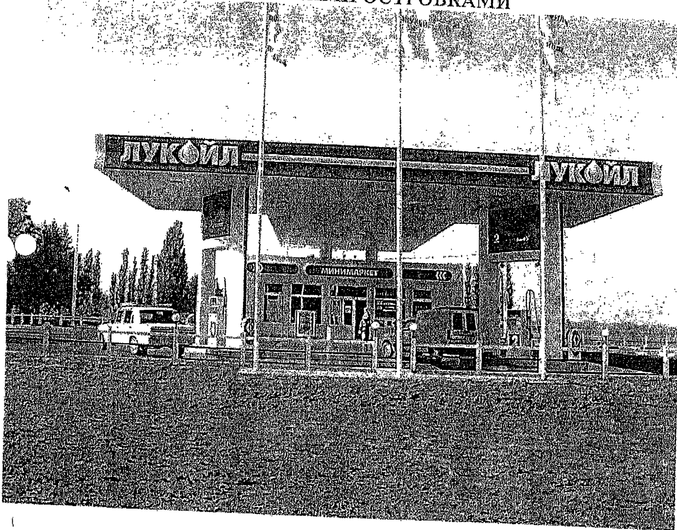
ФОТОГРАФИЯ ФАСАДА АЗС С ЗАПРАВочНЫМИ ОСТРОВКАМИ
